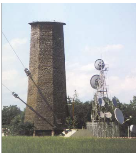
Kühlturm der Sendeanlage Dobl
